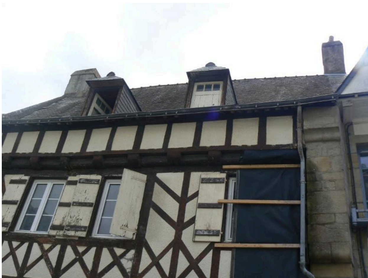
Façade à pan de bois avec encorbellement sur solives avant restauration
