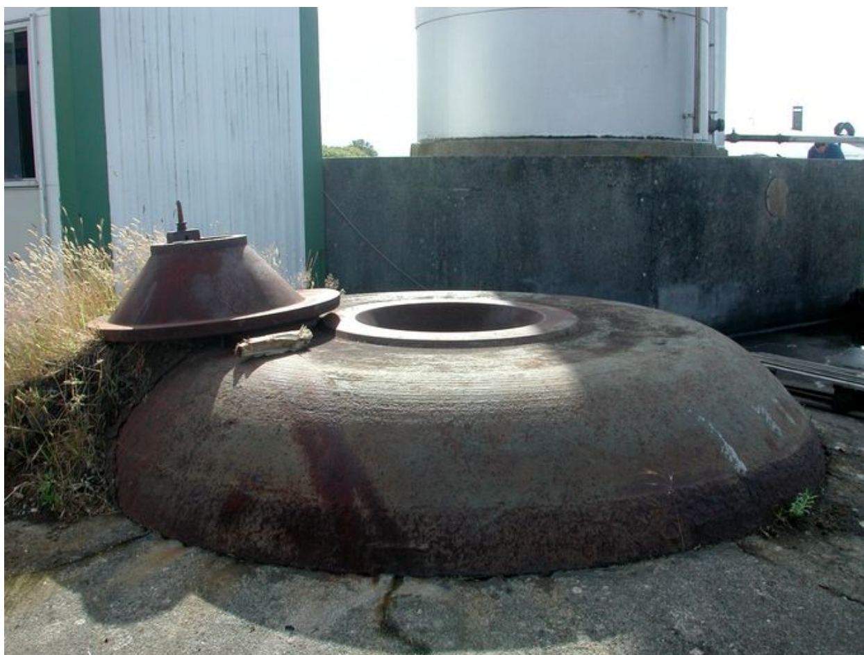
Vue du bunker de type 633 pour mortier (M19) du parc à carburant de Maison Blanche : cloche blindée
