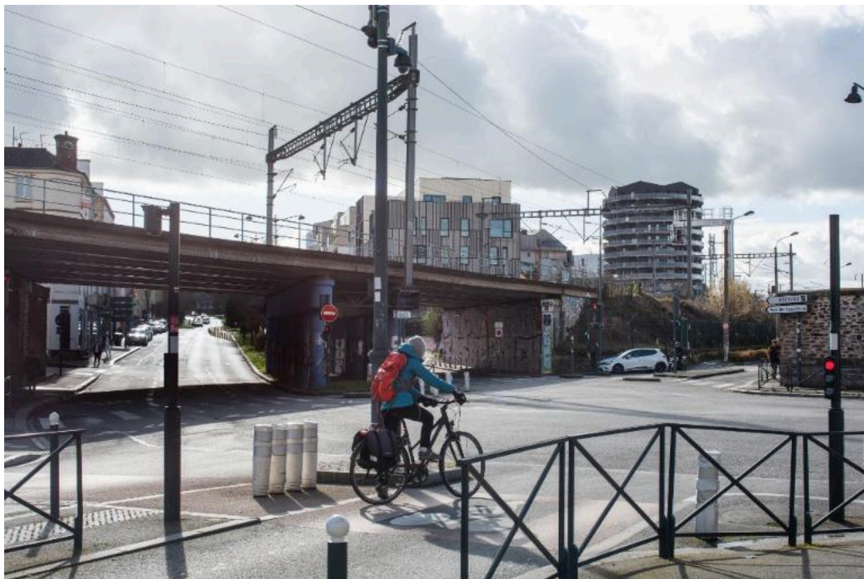
Vue générale du pont depuis le nord-est.
