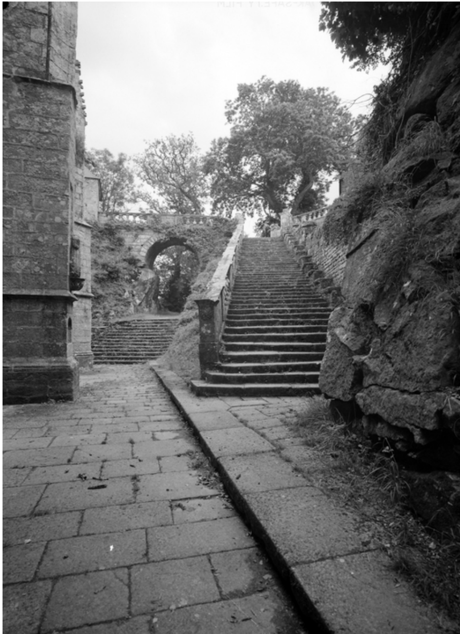
Vue générale du grand degré sud et du pont.
