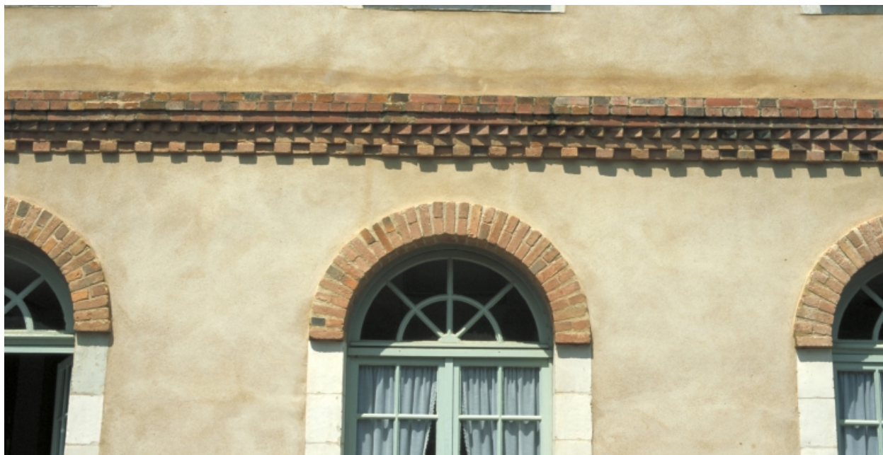
Détail sur la façade nord
