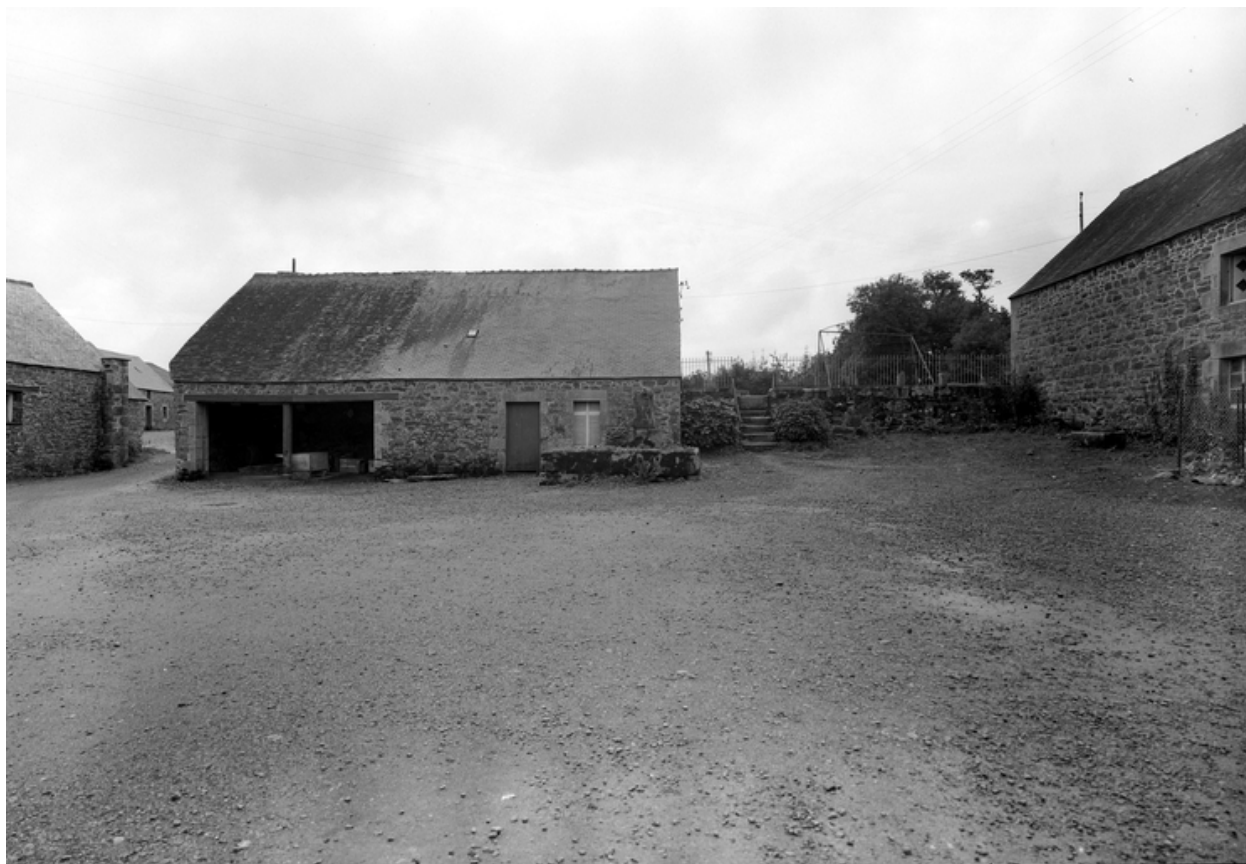
Vue du côté sud de la cour
