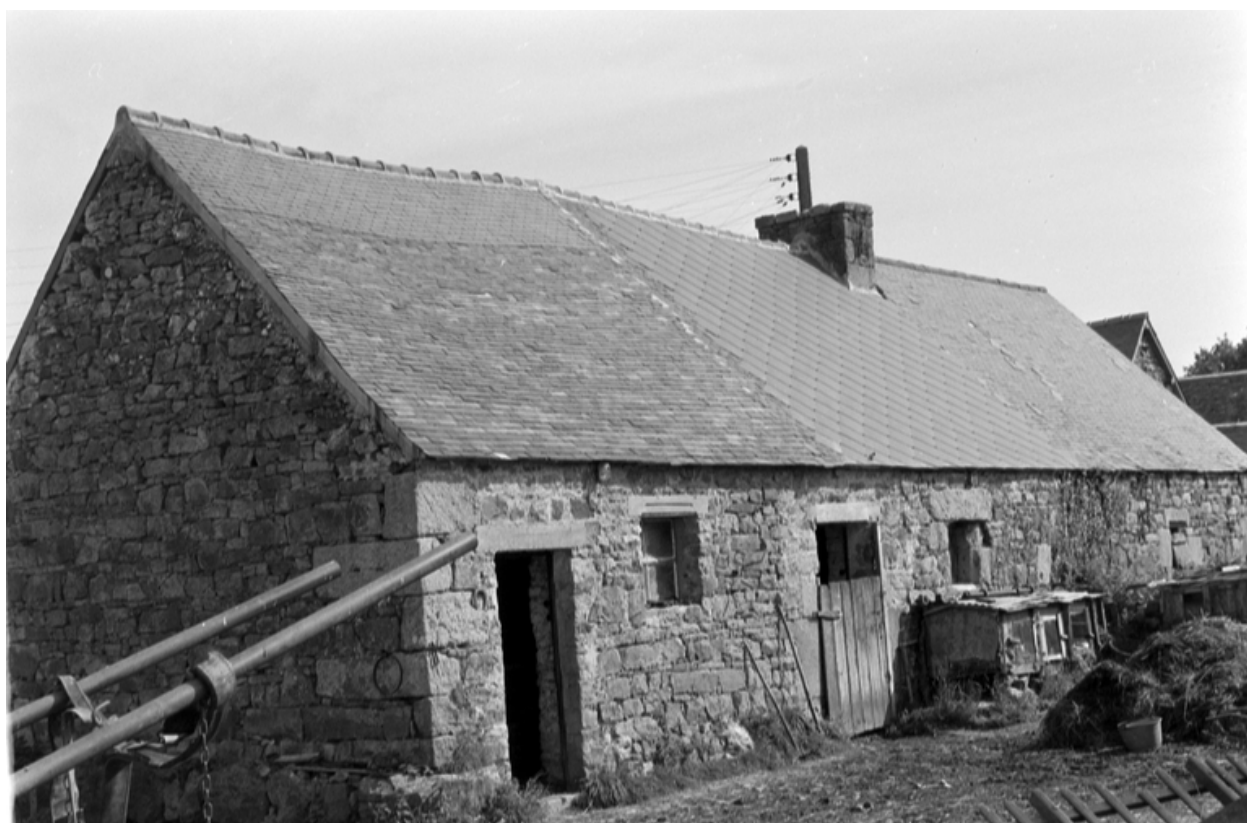
Maison (le château) : vue de la façade sud
