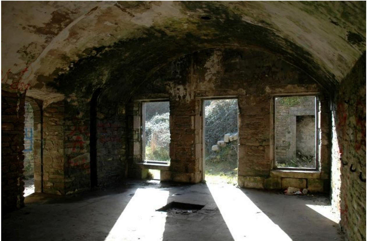
Vue de la chambrée de soldats nord vers la cour (état en 2006). A gauche, une porte permet de rejoindre directement le passage d'entrée. Vers la cour, porte encadrée de deux fenêtres. La trappe dans le sol permettait d'accéder à la citerne
