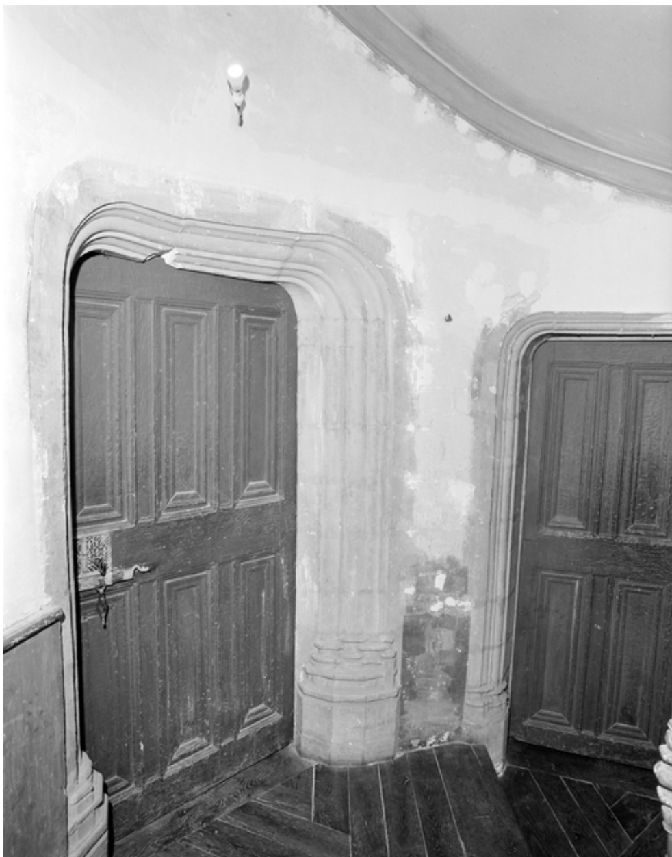
Etage : détail portes avec serrures découpées.
