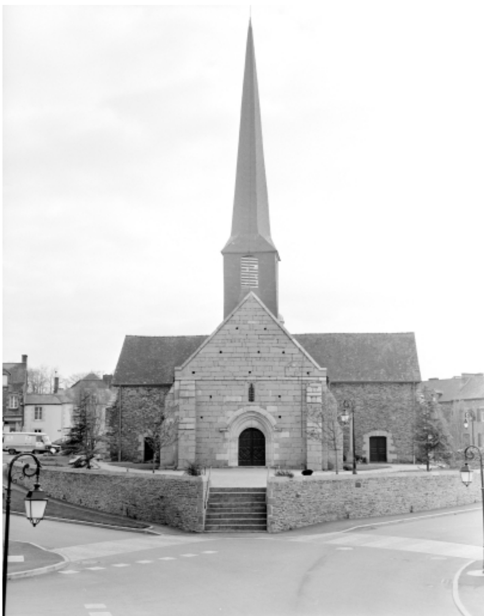
Vue générale ouest
