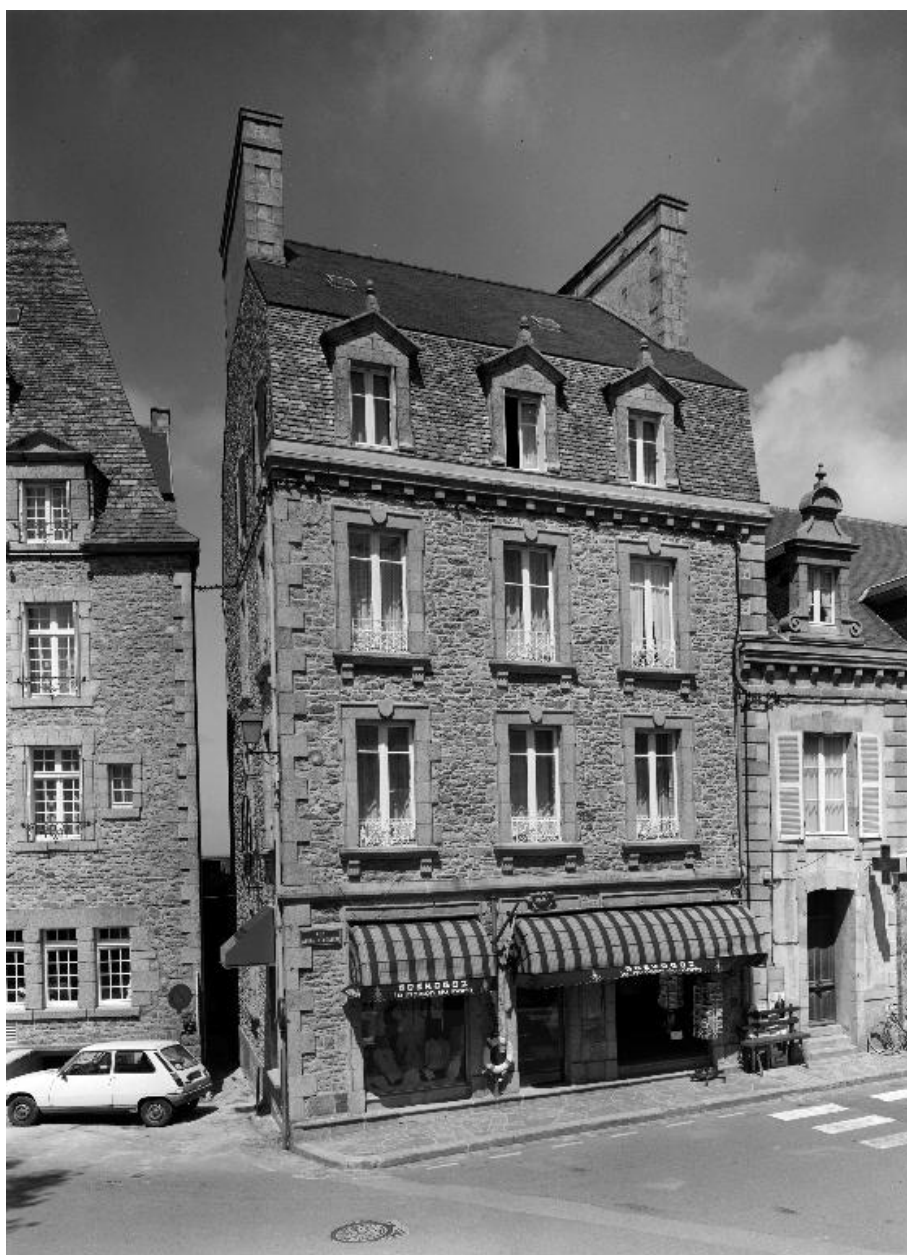
1 rue Amiral Reveillère, élévation sud, vue générale
