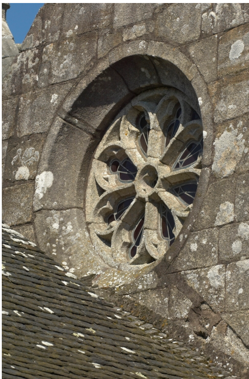
Travée du porche sud, rose dans le tympan du pignon
