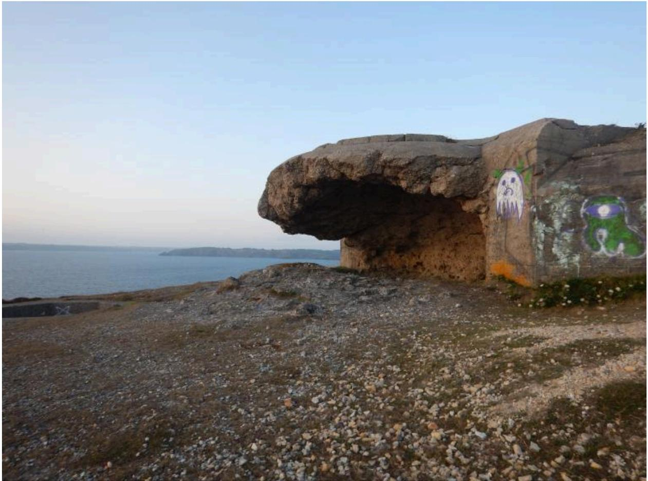
Vue de l'observatoire du bunker - poste de direction de tir de type 636a. Son observatoire a été partiellement détruit après-guerre lors des opérations de déminage
