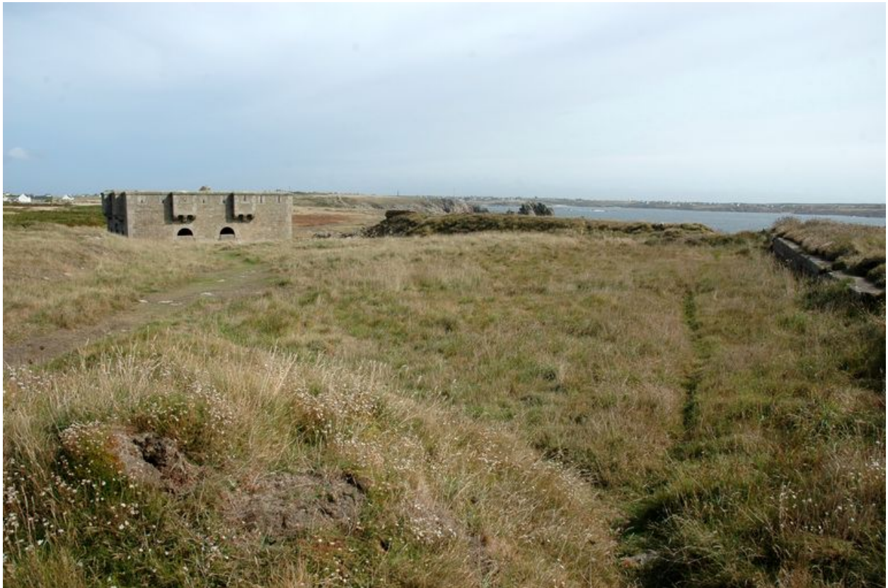
Vue générale du réduit et de la batterie de côte de Loqueltas
