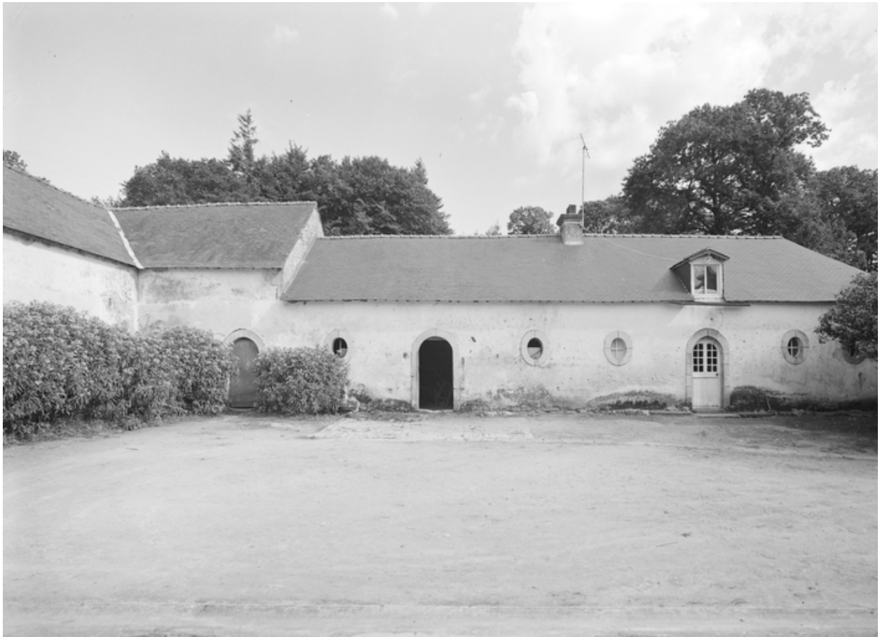
Communs, intérieur de la cour : vue générale prise du nord-ouest
