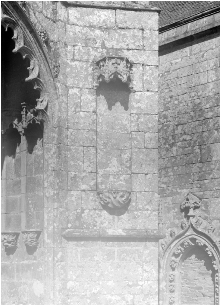
Niche du contrefort sud-est du porche sud.
