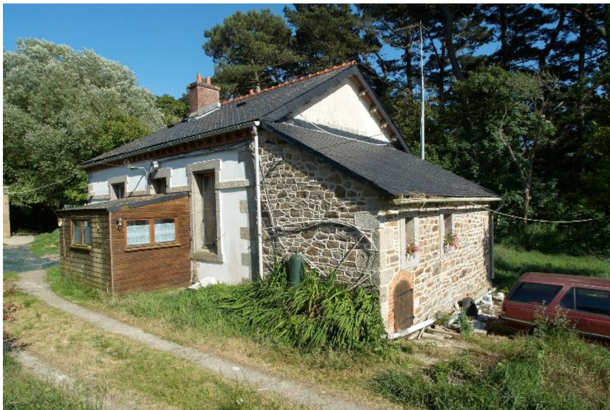
Vue de la maison - logement du gardien de batterie. Elle est dotée d'un appenti en maçonnerie sur son pignon
