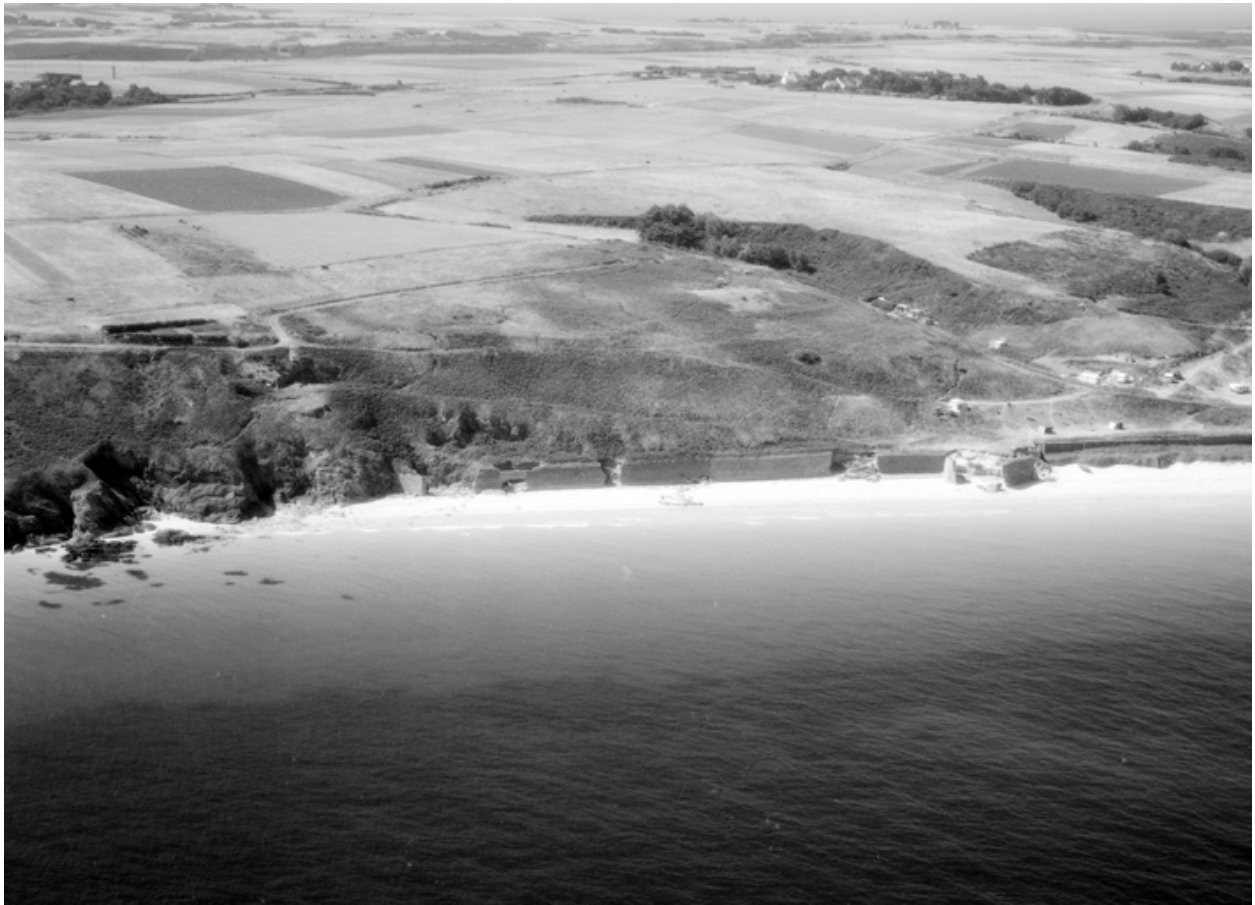
Vue aérienne prise du nord-est, partie est
