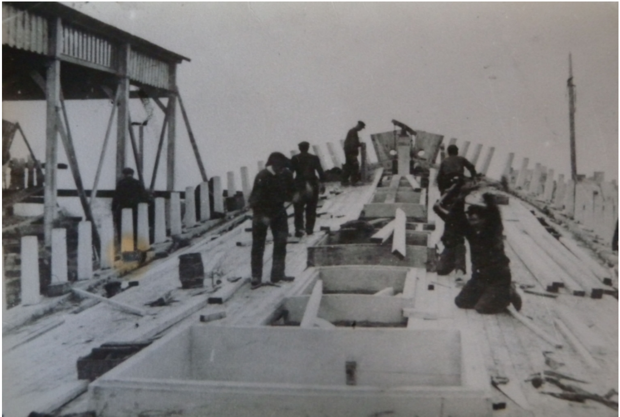
Vue des ouvriers sur une le pont d'un grand navire en construction, chantiers Bonne à Poulafret-Kérité, 1er quart 20ème siècle (collection particulière)
