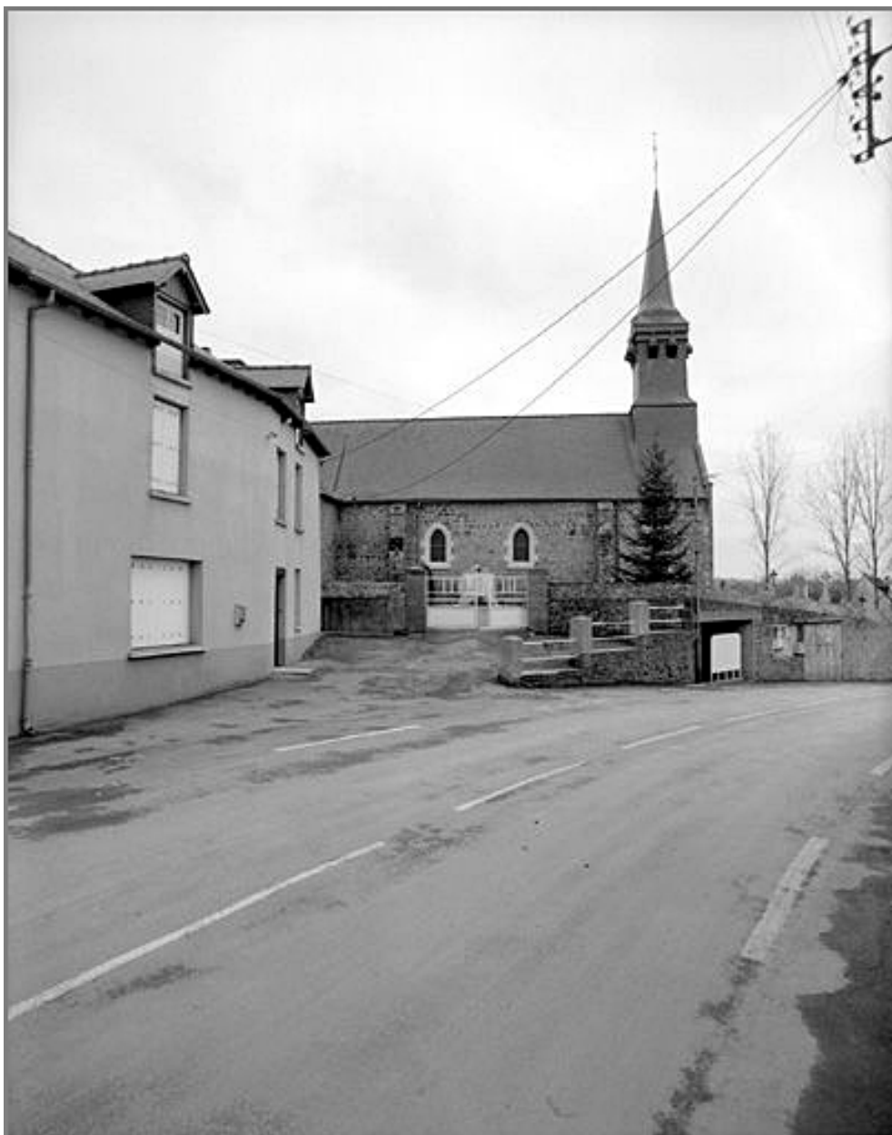
Elévation Nord, partie Ouest : vue générale
