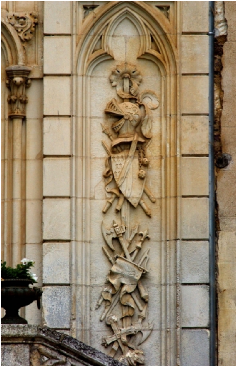
Façade antérieure, détail des armoiries sculptées
