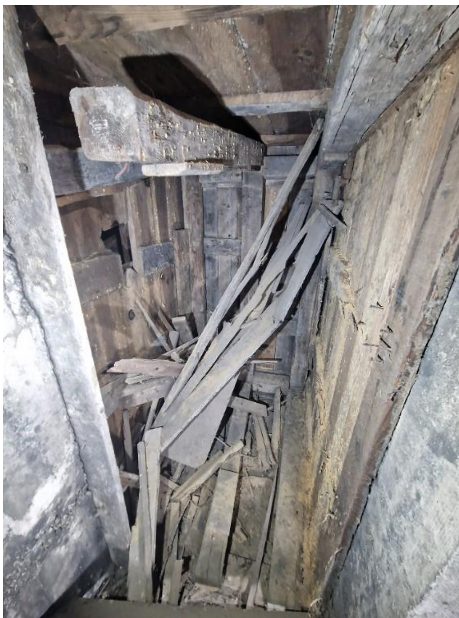
Vue de l'extension nord-ouest : coffrage d'origine dans l'une des casemates aménagées dans l'épaisseur du mur nord-ouest au troisième étage
