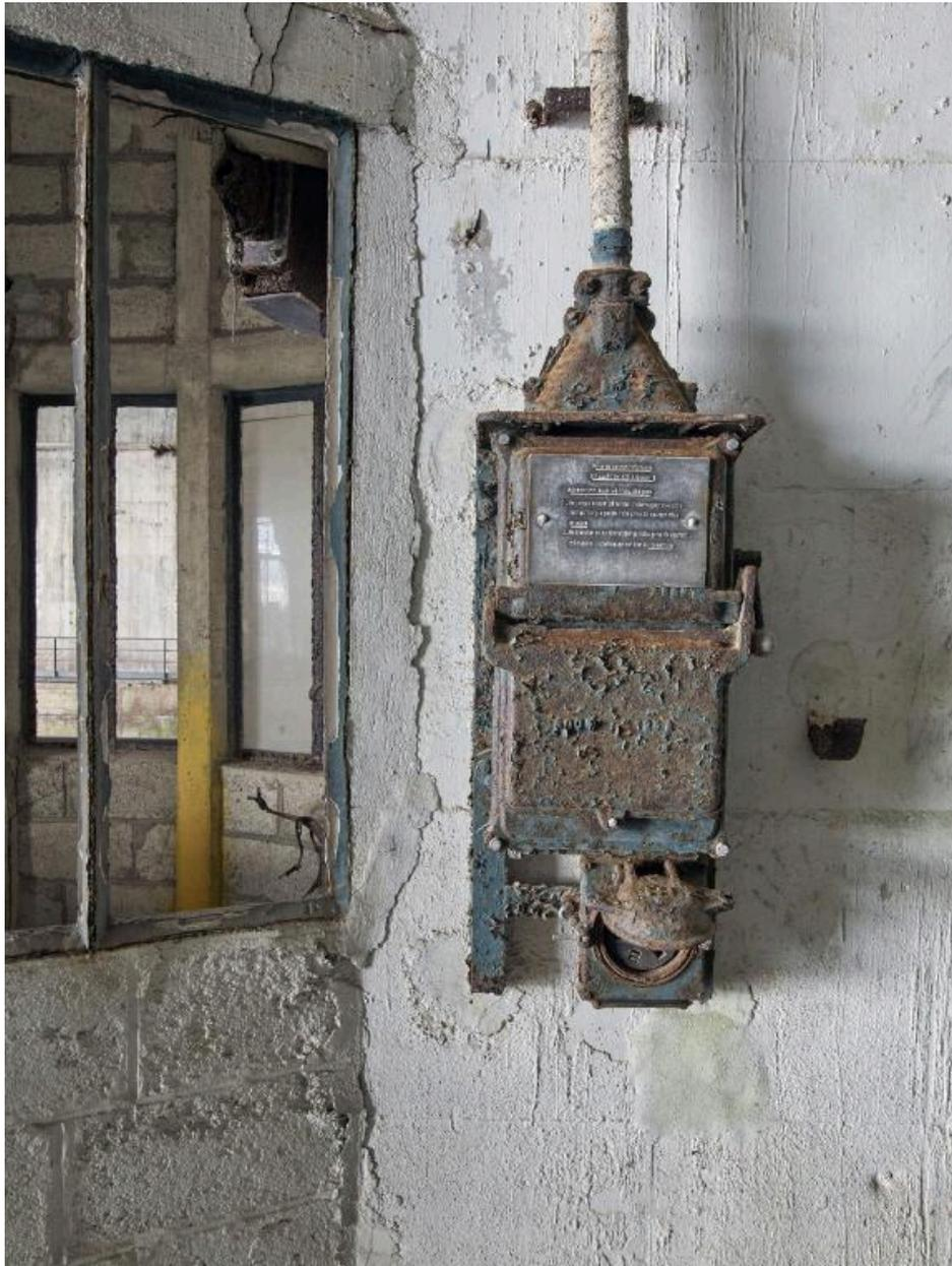
Vue du boîtier (fermé) de l'une des prises électriques triphasées du bassin D. Sur le boîtier : informations ("115 v 60 Hz 125 A Bassin D") et consignes de sécurité
