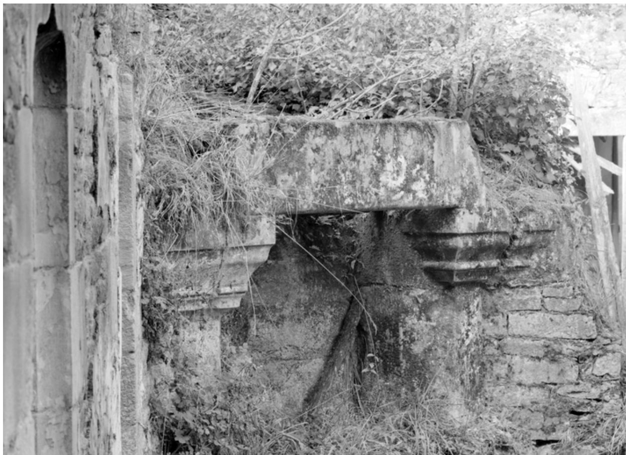
Etage, corps central, pièce est : cheminée de l'angle nord-ouest.
