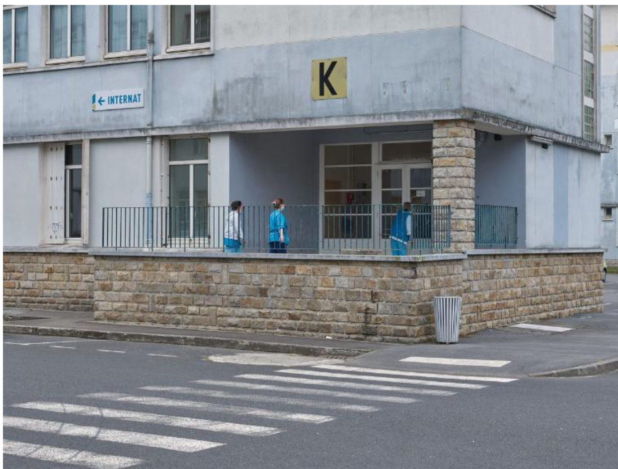
Bâtiment K, internat de garçons. Détail sur une entrée située à l'angle nord-est. J-B. Mathon, architecte.
