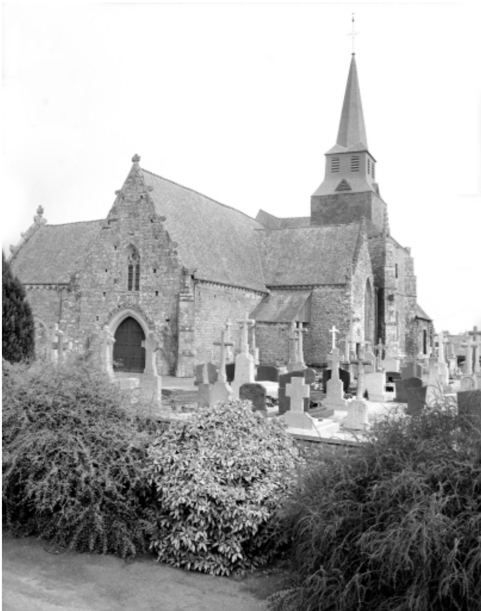
Elévation Sud-Ouest : vue générale
