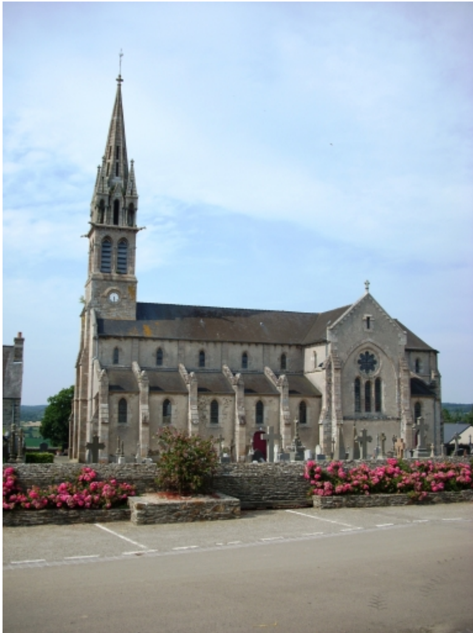
Garlan, église paroissiale Notre-Dame : vue générale sud-ouest
