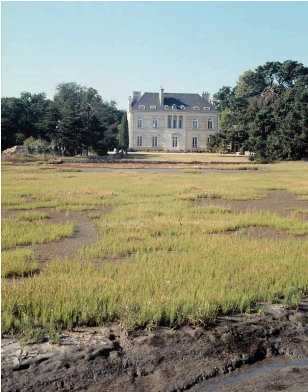
Vue générale nord.
