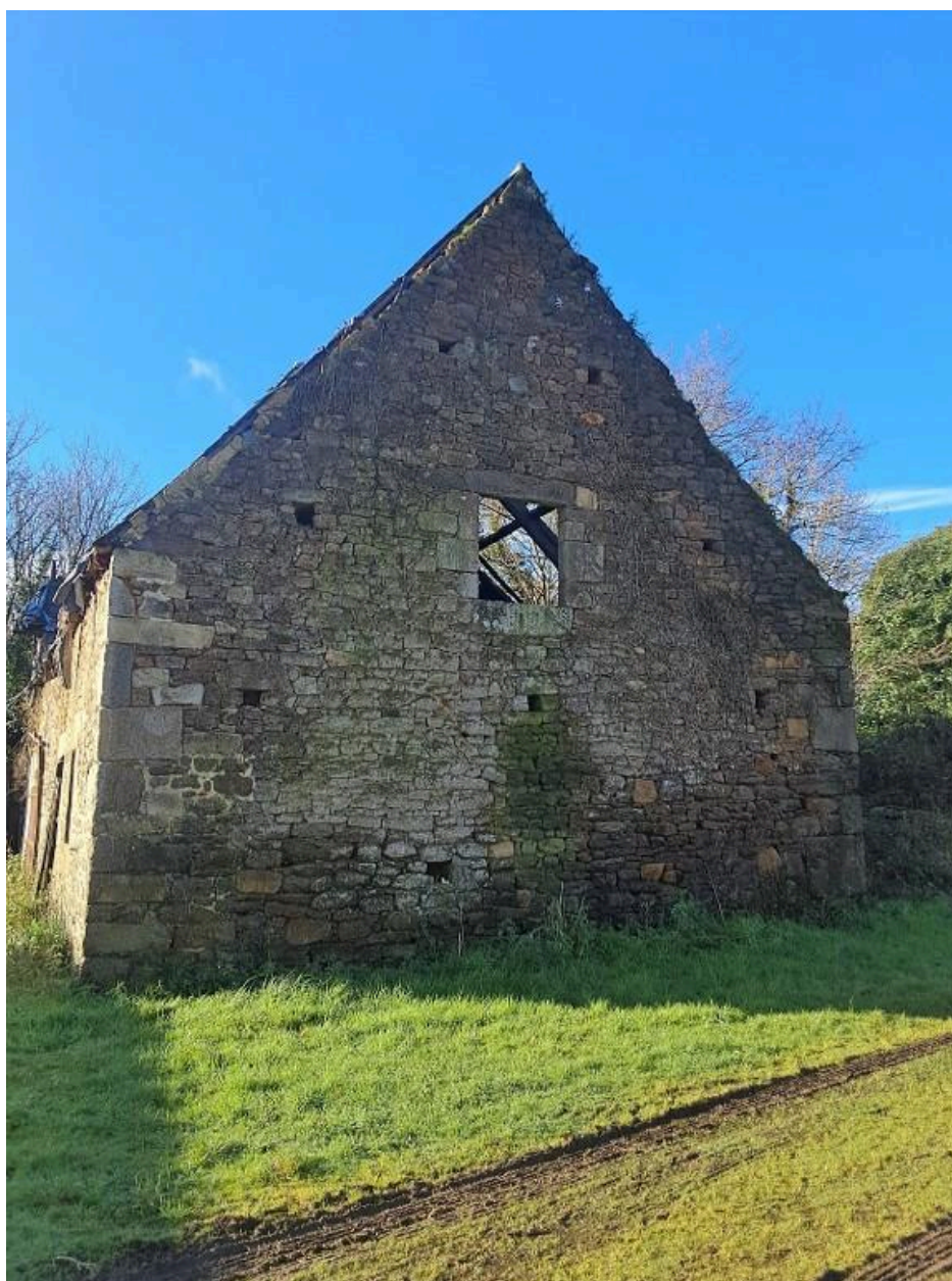
Dépendances, la grange, mur sud
