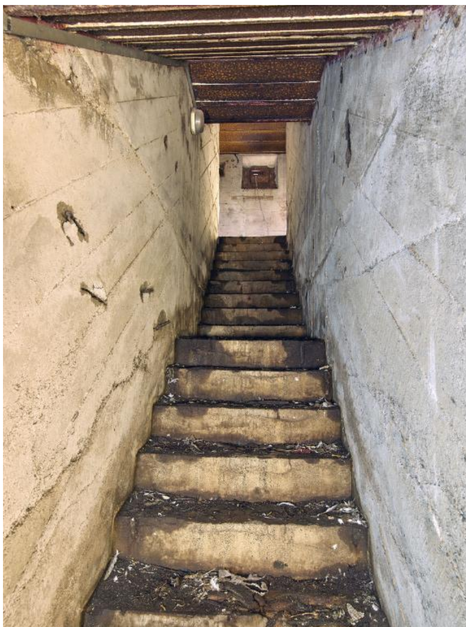
Vue intérieure : escalier desservant les deux cuves à canon
