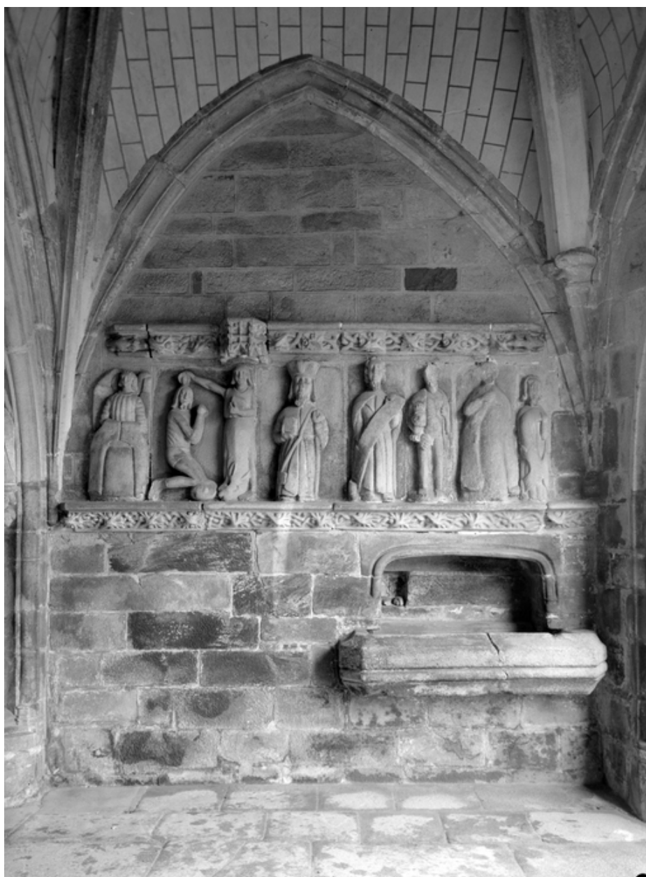
Statues du porche sud, vue d'ensemble du mur est.
