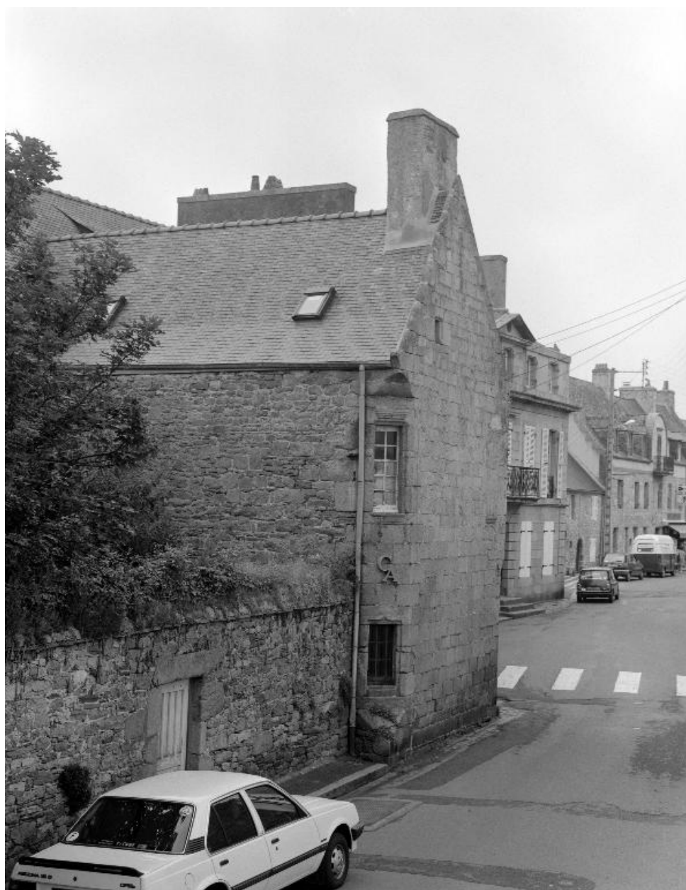
46 rue Gambetta, élévation sud-est, vue générale
