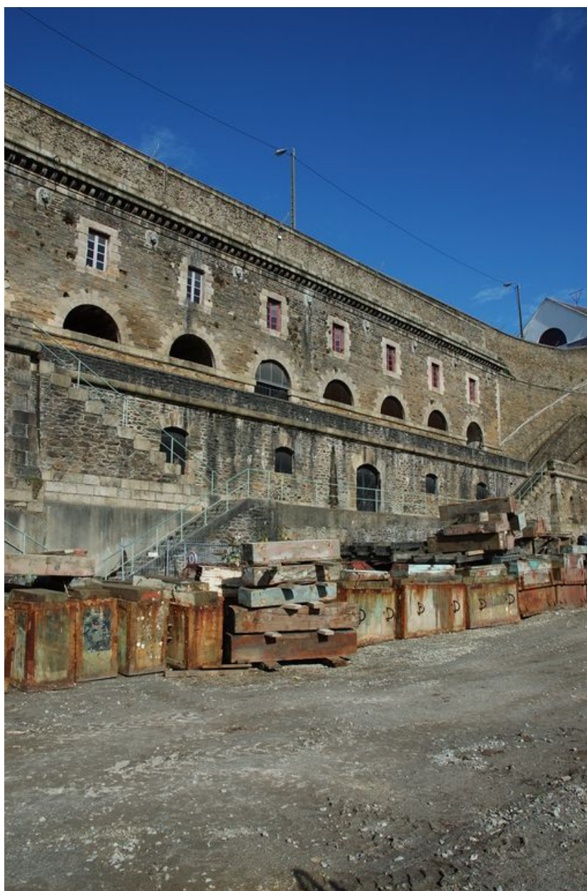
Vue de l'élévation orientale (contre-plongée)
