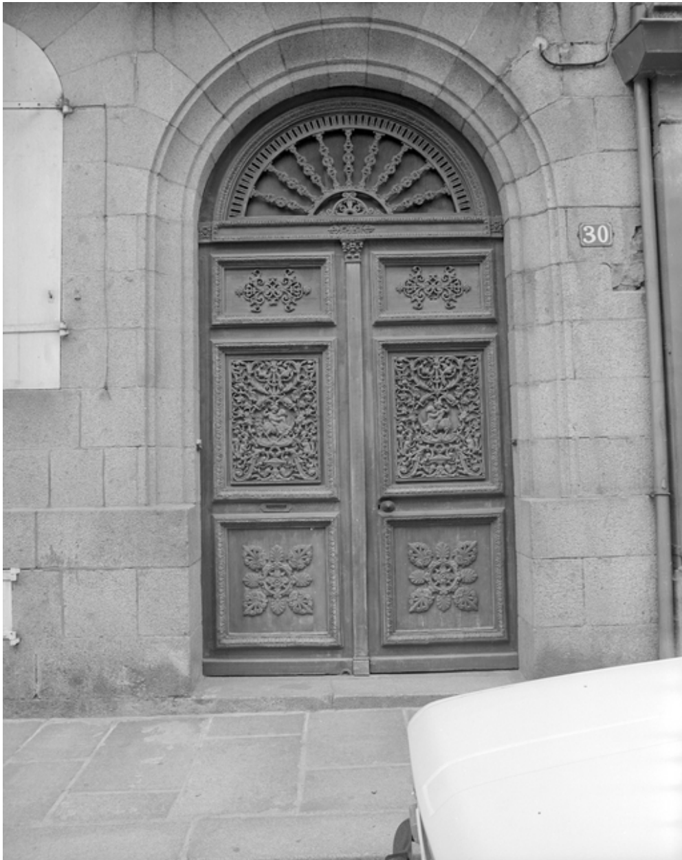
Vue générale de la porte d'entrée.
