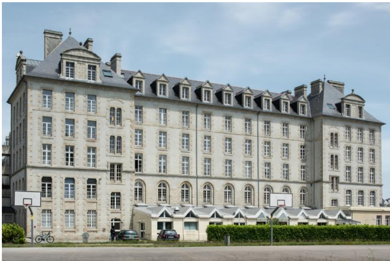
Ancien séminaire, aile sud-ouest, Henri Rapine, architecte, 1899. Au rez-de-chaussée bas, extension pour agrandir le réfectoire.
