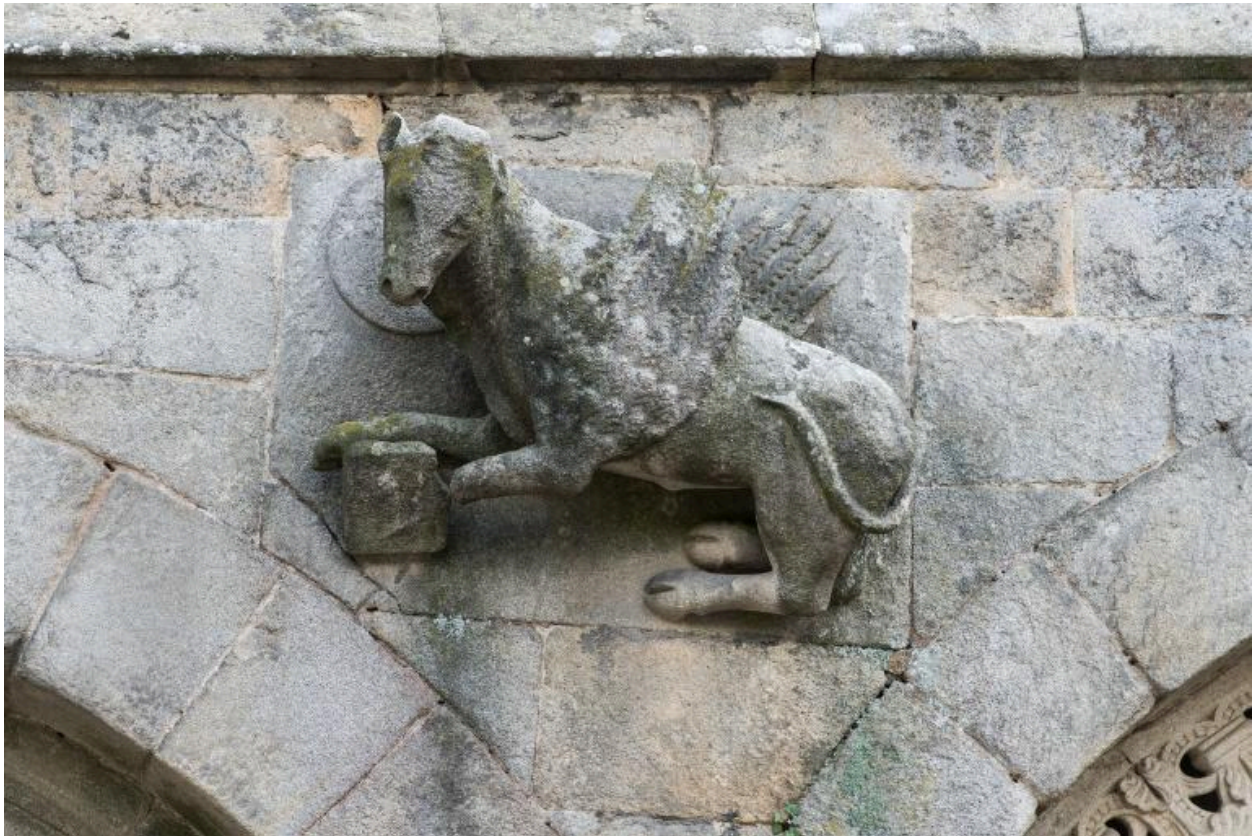
Façade ouest : le taureau de saint Luc
