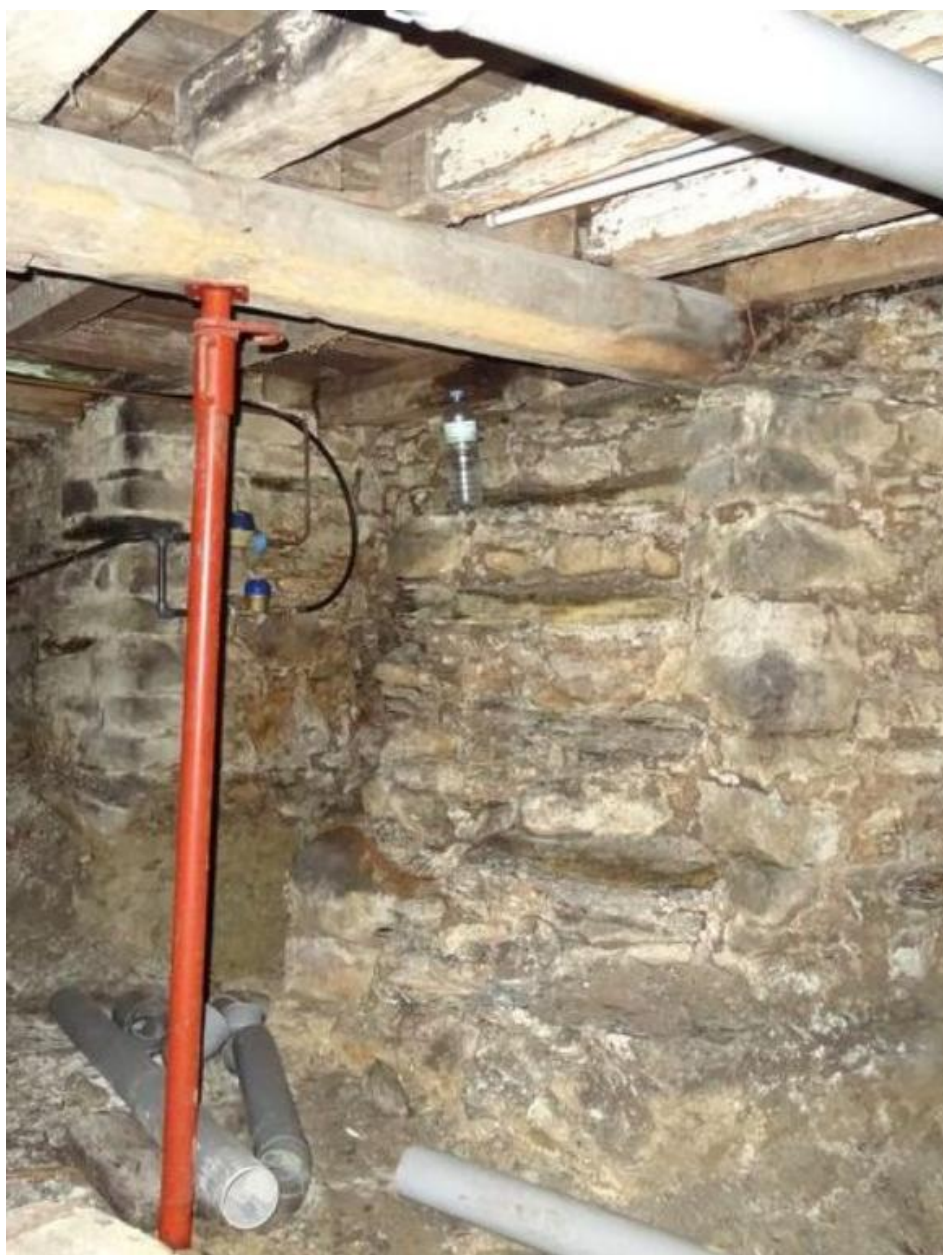
Vestiges d'un escalier, cave
