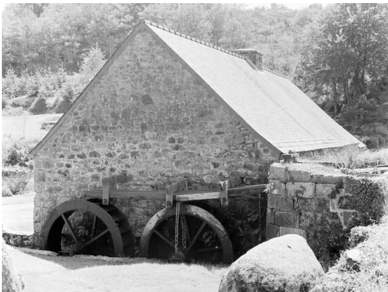
Vue générale des roues.
