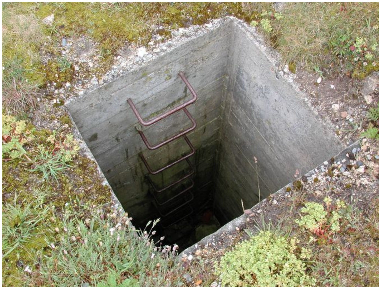
Vue de la sortie de secours avec ses échelons (état en 2003)
