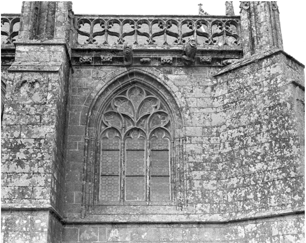
Façade sud, détail de la fenêtre du chœur, troisième travée.
