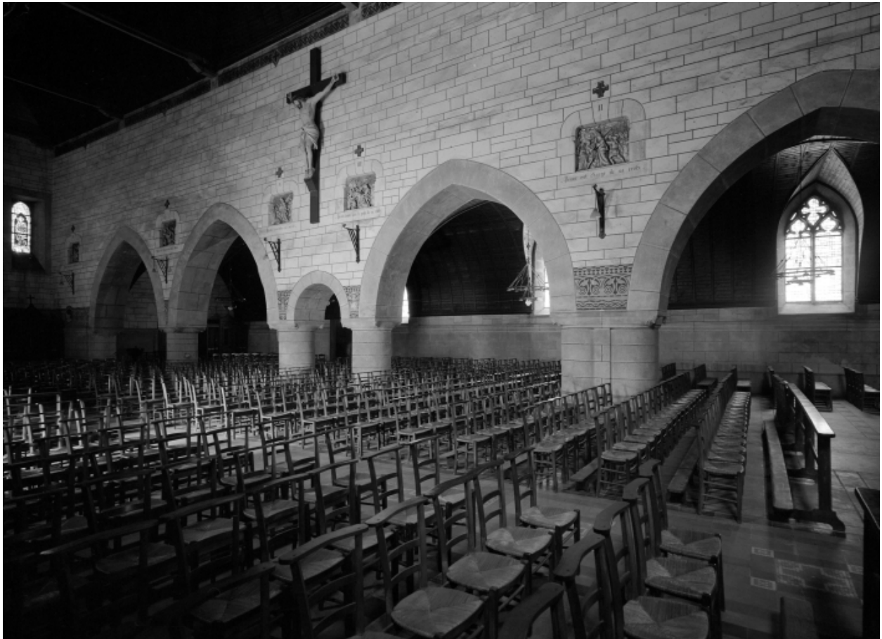
Intérieur, nef, arcades nord : vue générale.
