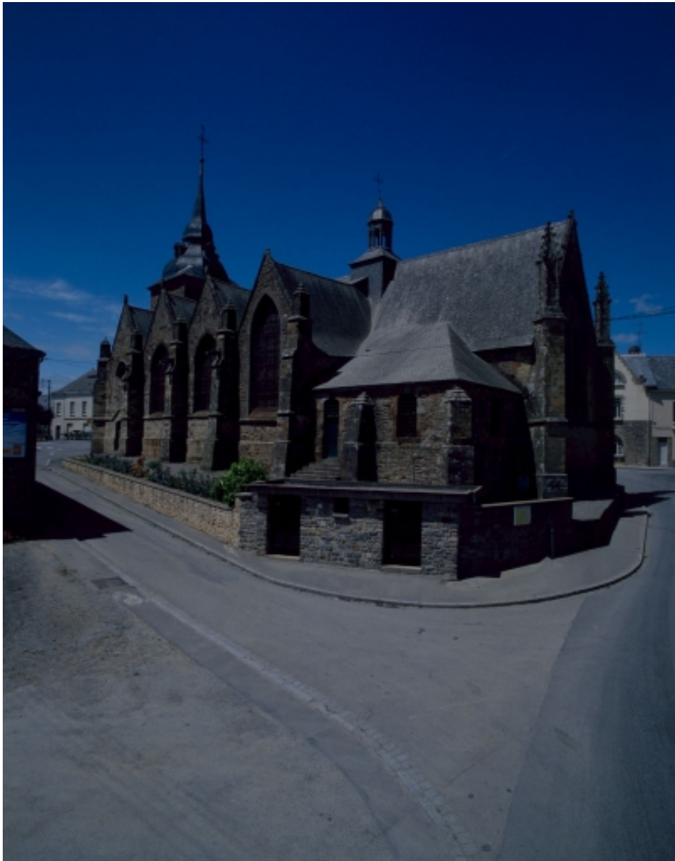
Élévation nord : vue générale
