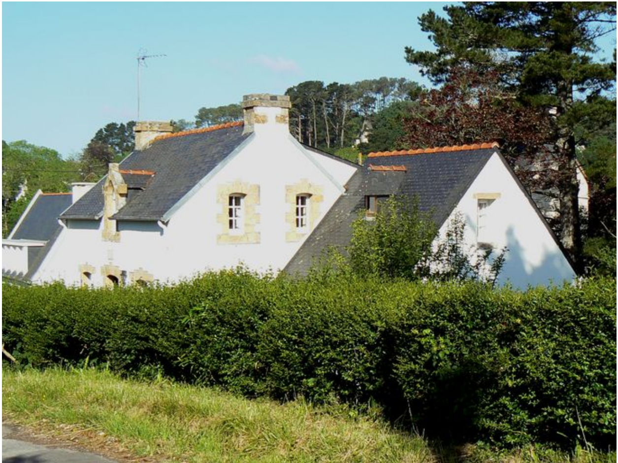
Vue générale de la villa Les Sapins
