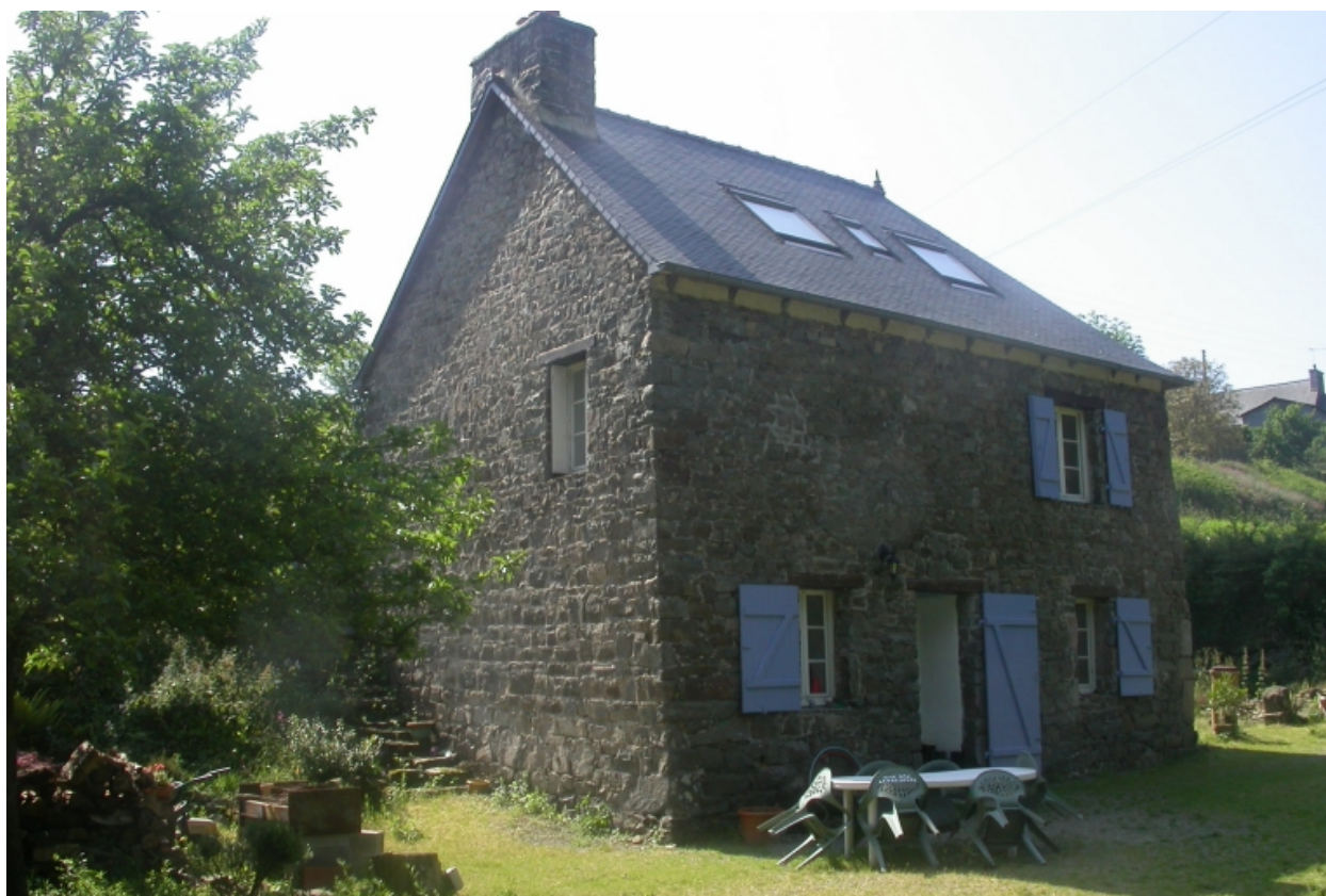
Moulin vu du nord ouest
