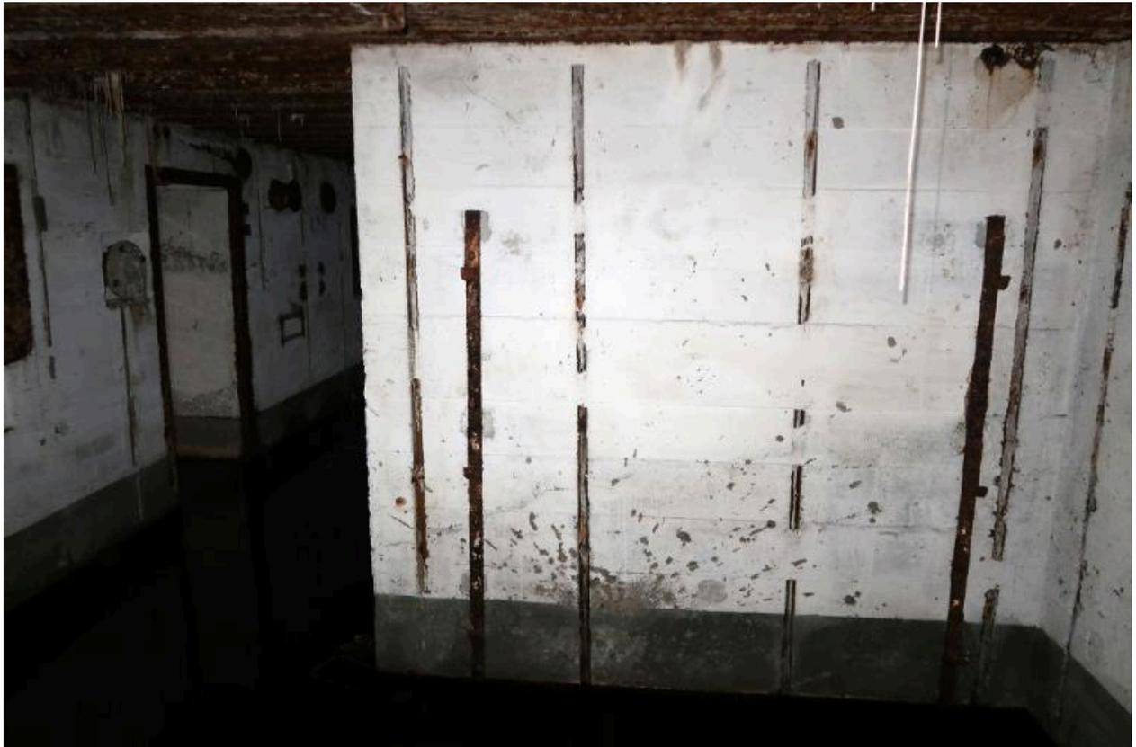
Vue intérieure : salle de garde nord, mur de refend avec les supports muraux pour trois couchettes tubulaires. Au niveau du sol, le mur montre les traces d'une explosion
