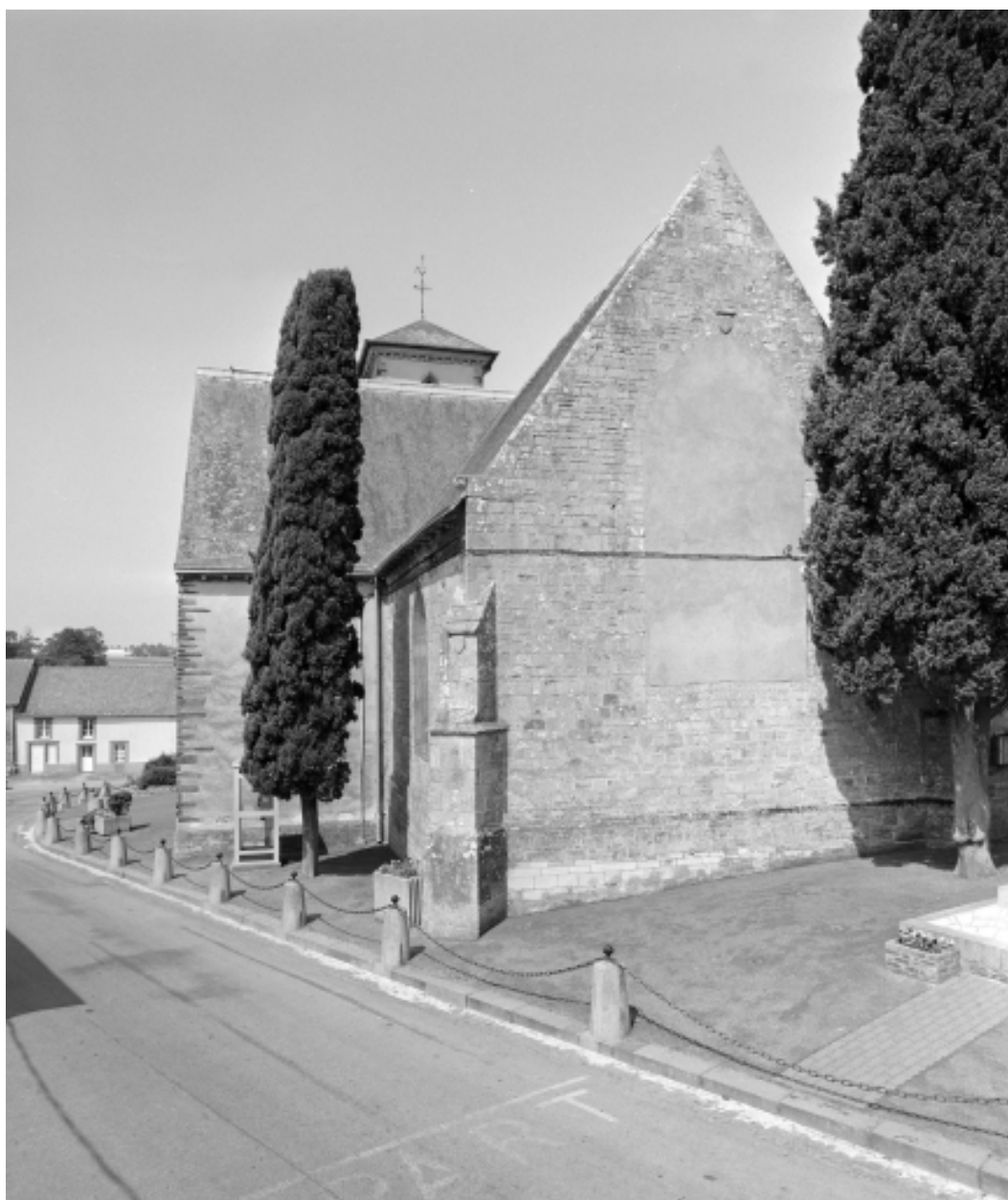
Vue générale est
