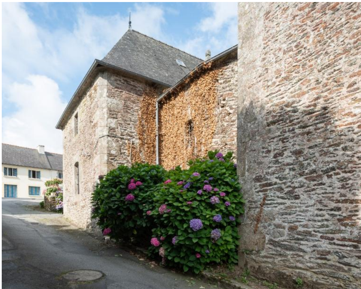
Sacristie, vue ouest
