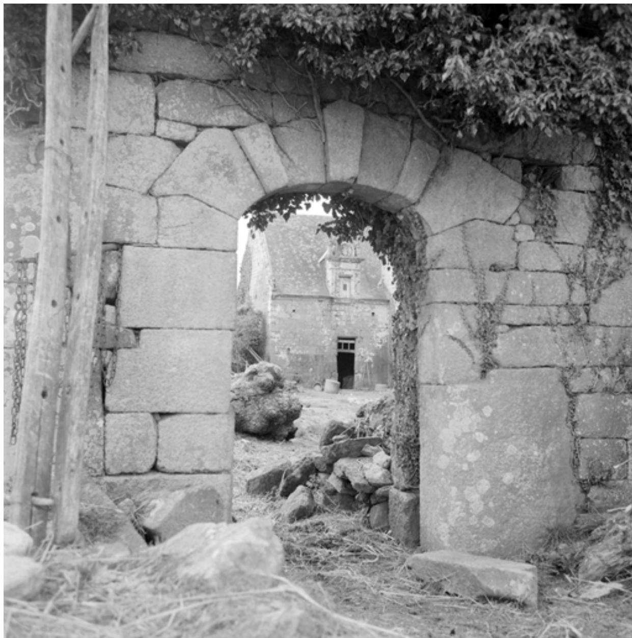
Vue d'ensemble du portail d'entrée.
