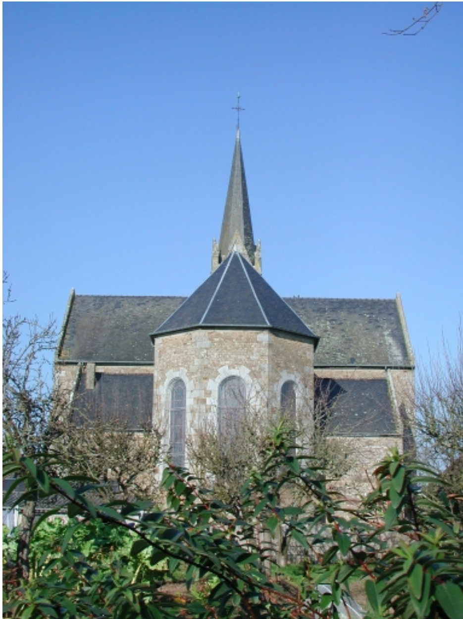
Vue nord de l'église
