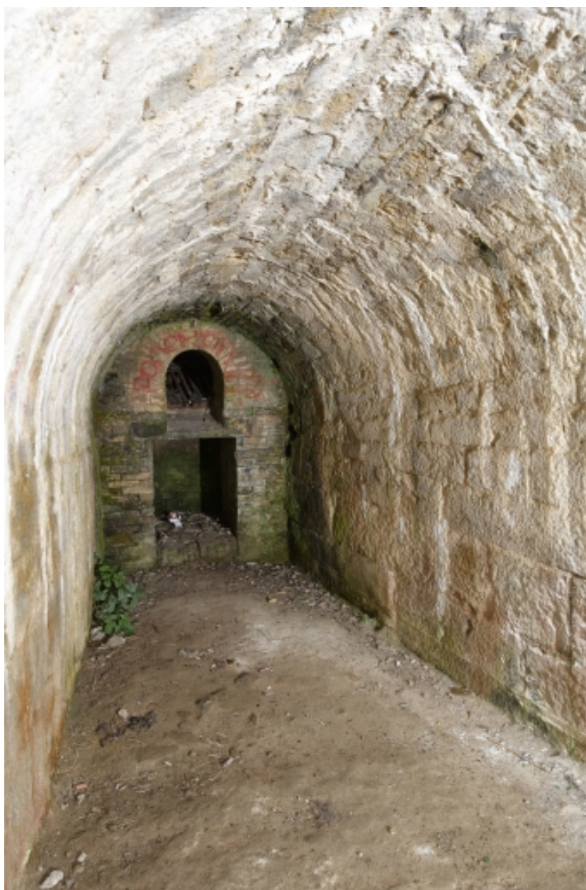
Galerie d'accès à la bouche de défournement
